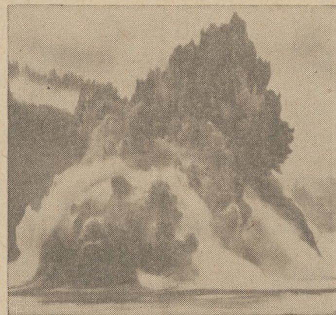
USUNIĘTA ZAWADA W ŻEGLUDZE NA CAMPBELL RIVER, B. C. — Dwie bliźniacze skały, znajdujące się pod wodą na Campbell River, B. C., były powodem uszkodzenia ponad 100 statków żeglujących po rzecze. Silny ładunek dynamitu założony pod nie, zaważył, dając przyspieszenie widokowi. Do wydobycia użyto 1,375 ton materiału wybuchowego.
