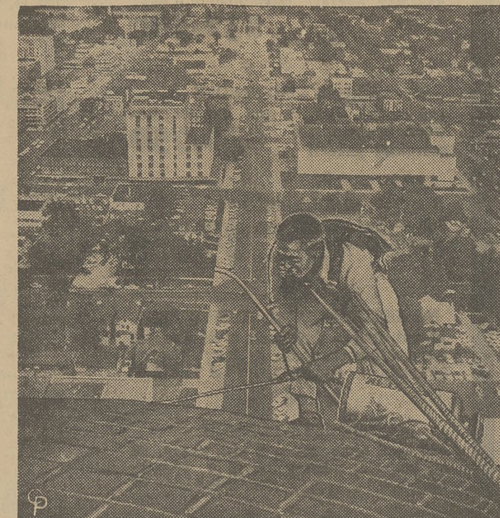
PRACA WYMAGAJĄCA NERWÓW. Główny mieszczący biura stolicy stanu Nebraska, Lincoln—obecnie przechodzi swe odnowienie. Oto robotnik zawieszony na linie na wys. 400 stóp nad ziemią, odcyszczający kopułę i figurę "Święty", na gmachu stolicznym biura Nebraska.
