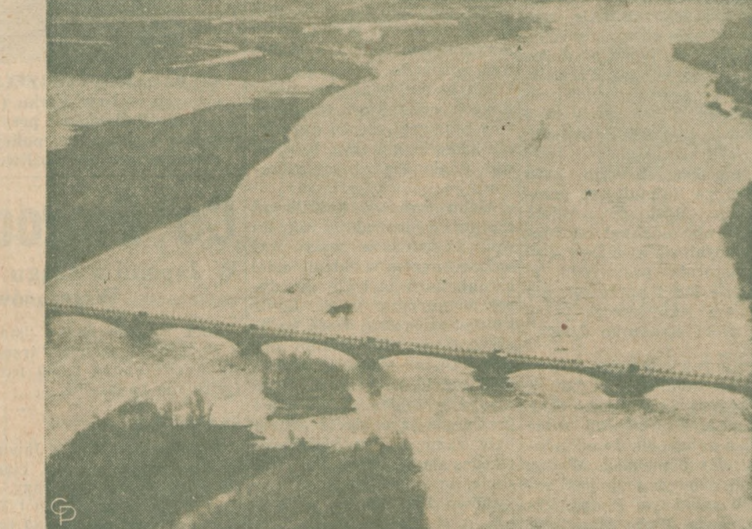
W NASTĘPSTWIE ulewnych deszczów wezbrała rzeka Eel i zalała żyzną dolinę Fendale, położoną o 20 mil na południe od Eureka w Kalifornii. Poziom wód rzeki Eel podniósł się o 28 stóp, powodując katastrofalną powódź.
