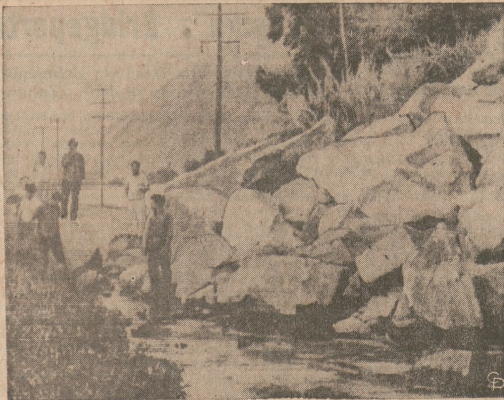
SKUTKI TRZĘSIEŃ ZIEMI. — Ratownicy stoją obok skał, obsuniętych na szosę w pobliżu Limy, stolicy Peru, podczas trzęsienia ziemi, które pozbawiło życia ponad 1,000 osób oraz zrównało z ziemią tysiące domów i budynków w całym kraju wzdłuż Andów.
