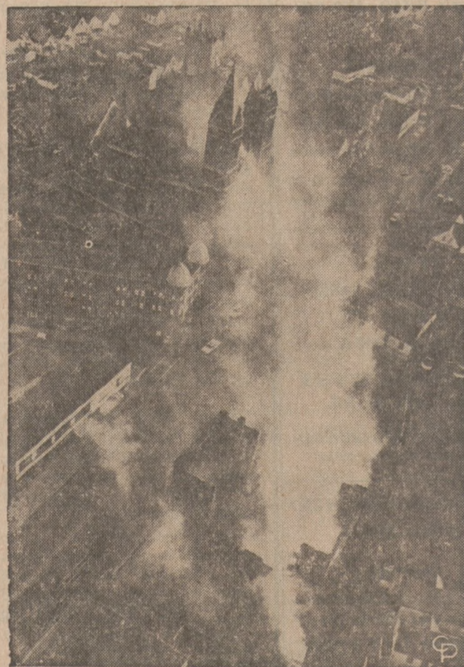
W WYNIKU POŻARU jaki wybuchł w Cleveland zniszczony został kościół St. Francis Catholic Church (u góry po prawej), szkoła przy kościele oraz opuszczonego budynku mieszkaniowego (u dołu po lewej). Poniesione straty w wyniku pożaru ocenia się na $1 mln. Policja i straż pożarna prowadzą intensywne dochodzenie w sprawie pożaru, który jak istnieje przypuszczenie został spowodowany umyślnie.
