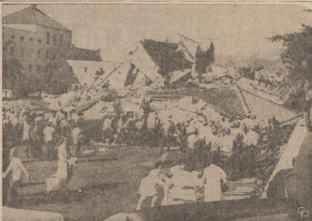
SAN FERNANDO — Najwięcej ofiar zanotowano właśnie w tym mieście po nawiedzeniu południowej części stanu Kalifornia przez silne trzęsienie ziemi. Na zdjęciu: akcja ratownicza po zawaleniu się Szpitala dla Weteranów.
