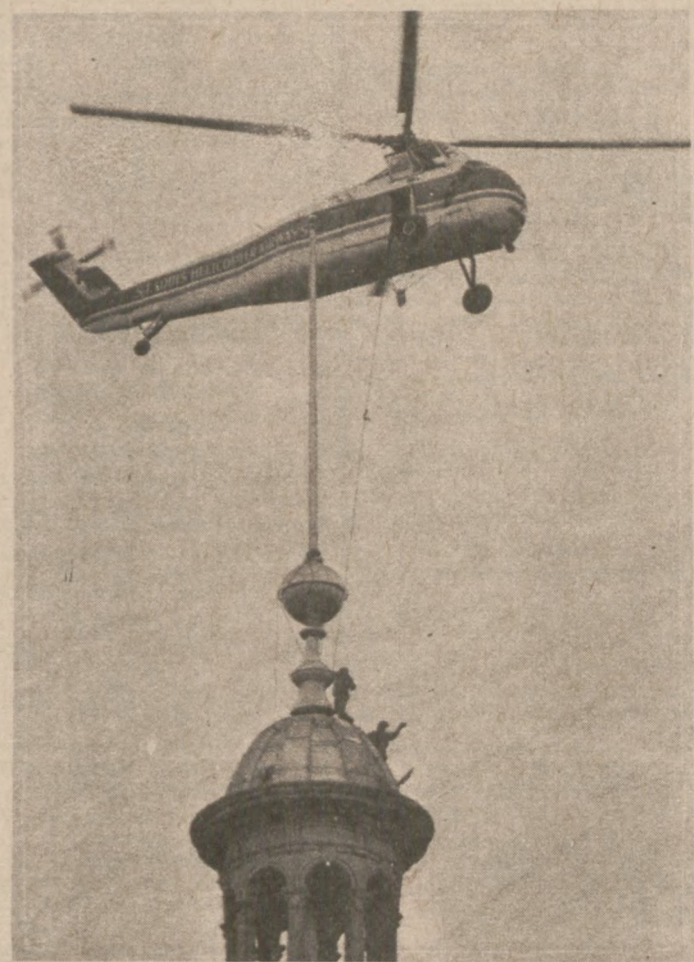
SPRINGFIELD, ILL. — Robotnik stojący na dachu kopuły Stanowego Kapitolu daje sygnały pilotowi helikoptera, który wiezie nowy maszt flagowy celem ustawienia go na kopule. Maszt ten waży 3,400 funtów i kosztował $22,000. (UPI)
