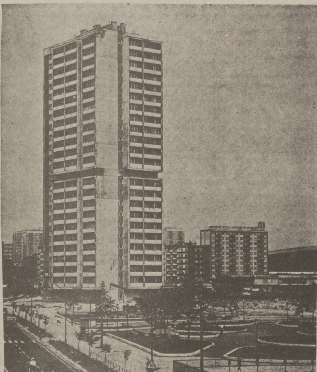
POLSKA, KATOWICE. — Fragment centrum miasta, z największym 22-piętrowym wieżowcem mieszkalnym.
