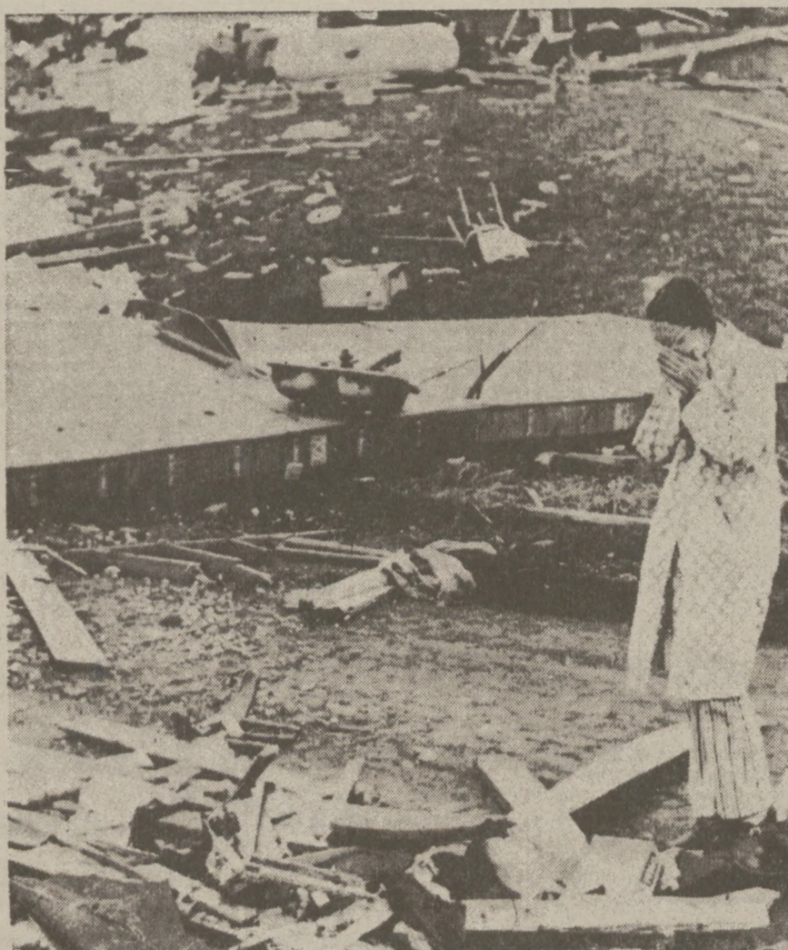
DOUGLASVILLE, GEORGIA. — Pani Hermanowa Hernandez nie może powstrzymać łez na widok szczątków jej domu, zburzonego przez tornado.
