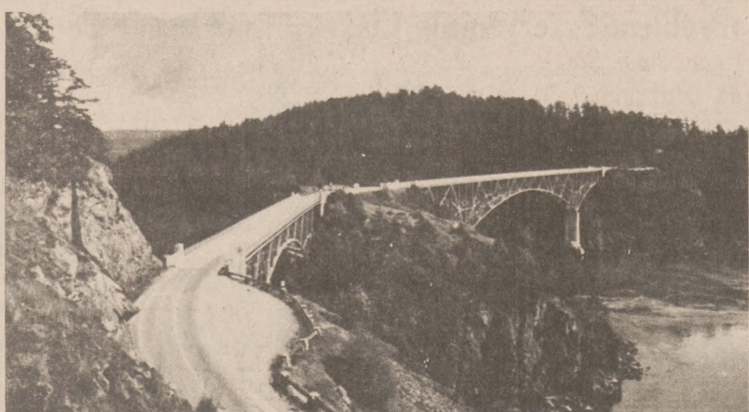
Na zdjęciu most zwodzony — Deception Pass Bridge — który łączy wyspę Fidalgo w stanie Washington, z jedną z największych wysp w Stanach Zjednoczonych — Whidbey.
