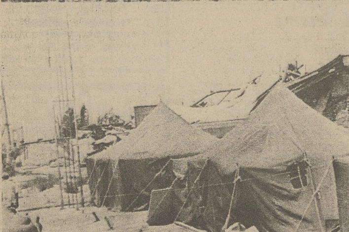
GAZLI, ROSJA. — Fotografie przedstawiają zniszczenia spowodowane trzęsieniem ziemi w centralnej Rosji. Jak podaje agencja TASS, prawie wszystkie domy i budynki w mieście Gazli zostały zniszczone.
