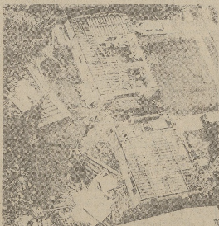
DALLAS — Dachu dwóch budynków widocznych na zdjęciu zostały zerwane w czasie tornada które w godzinach rannych przeszło przez miasto. (UPI)
