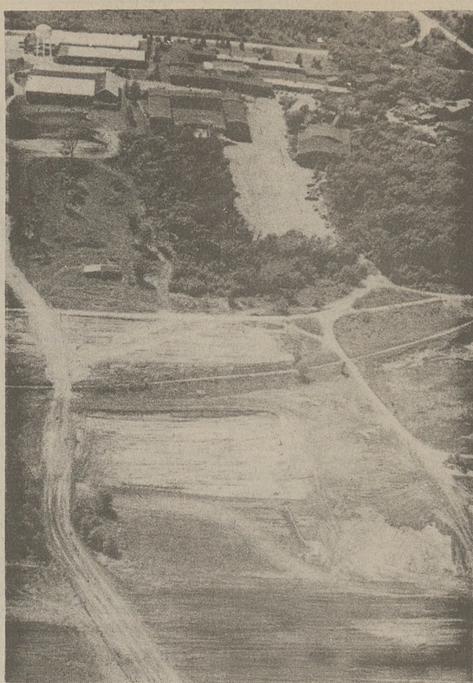
ROCKTON, ILL. — 340-akrowe lotnisko Wagon Wheel przechodzi znaczne zmiany. Po śmierci założyciela lotniska Walta Williamsona w 1975 nowi właściciele rozpoczęli szereg poważnych projektów konstrukcyjnych.
