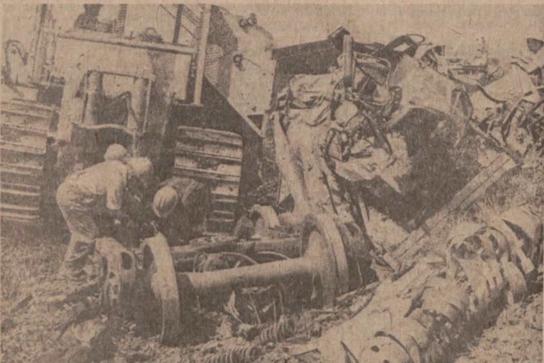
EDGAR, NEB. — Robotnicy oczyszczają tor kolejowy po wypadku, w którym wykołeił się pociąg złożony z trzech lokomotyw i 39 wagonów wiozących węgiel po zderzeniu z ciężarówką. Nikt nie odniósł poważniejszych obrażeń w wypadku. (UPI)
