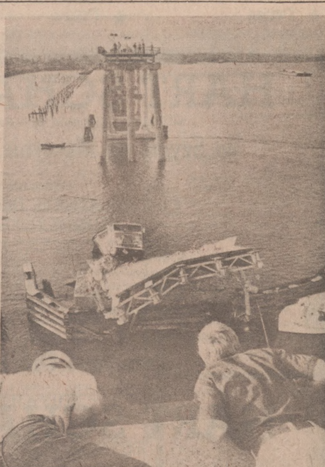
MANCHAC, LA. — Inżynierowie stanowego departamentu drogowego badają most który zawałił się kiedy uderzyła w niego płynąca barka. Nurkowie wyłowili przynajmniej jeden samochód. (UPI)
