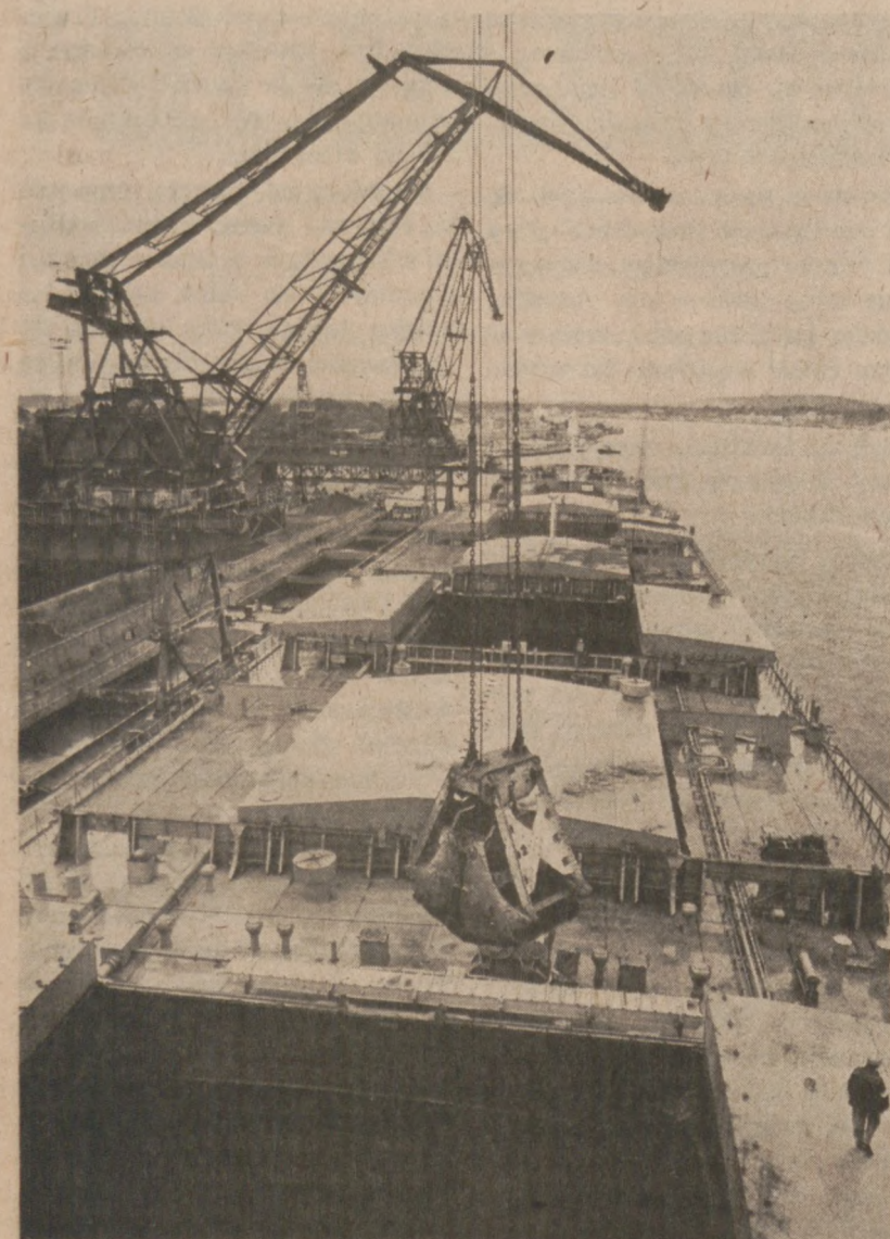
ŚWINOPORT—PORT PÓŁNOCNY SZCZECINA. — Specjalne urządzenia przeładunkowe zdolne są załadować w ciągu doby 30 tys. ton węgla, a składowiska wyposażone w dalekosiężny układ taśmociągów mogą pomieścić 440 tys. ton węgla.
