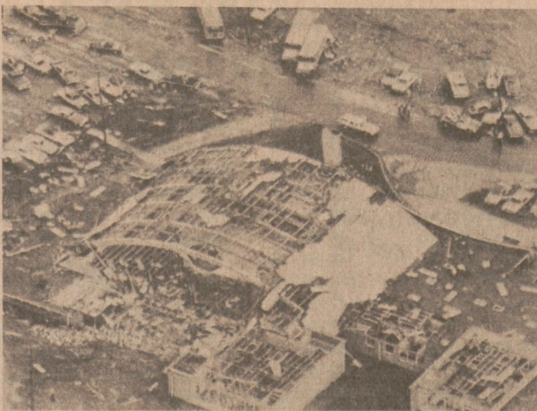
PLEASANT HILL, MO. — Widok hali gimnastycznej szkoły średniej w Pleasant Hill zniszczonej przez tornado. Trzy osoby poniosły śmierć.
