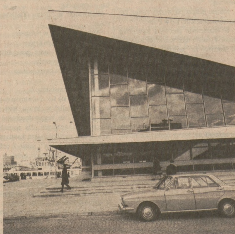
Nowy dworzec pasażerski od strony Nadbrzeża Pomorskiego
