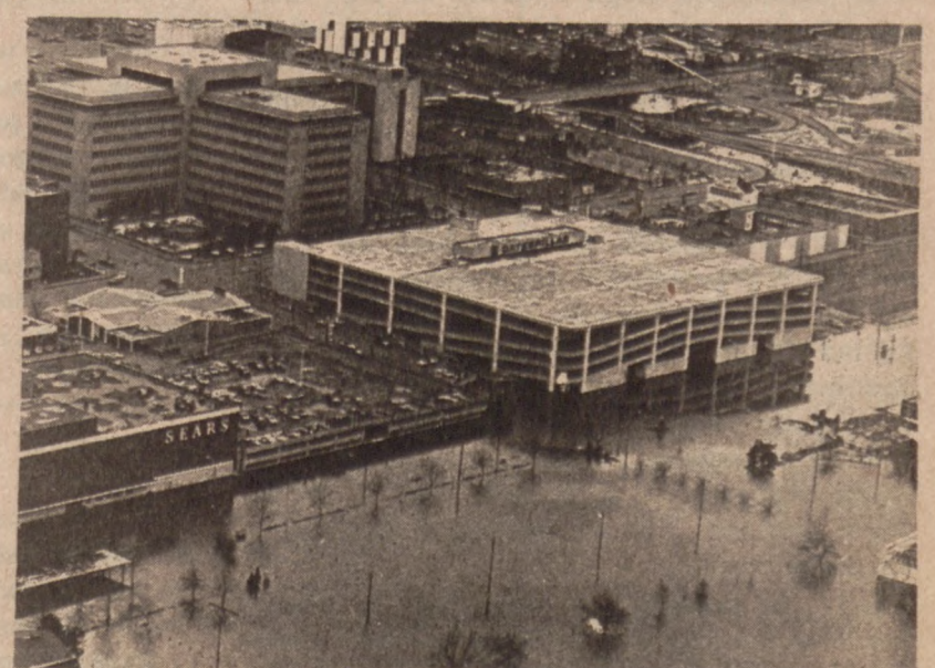
PEORIA, ILLINOIS. — Przybór wody na rzece Illinois spowodował zalanie dużej części miasta. (UPI)
