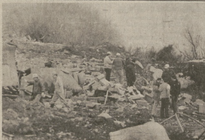
LEHI, UTAH — Eksplozja ładunku wybuchowego w kompanii chemicznej IRECO Chemical Company zrównała z ziemią dwupiętrowy budynek, zabijając czterech pracowników. (UPI)
