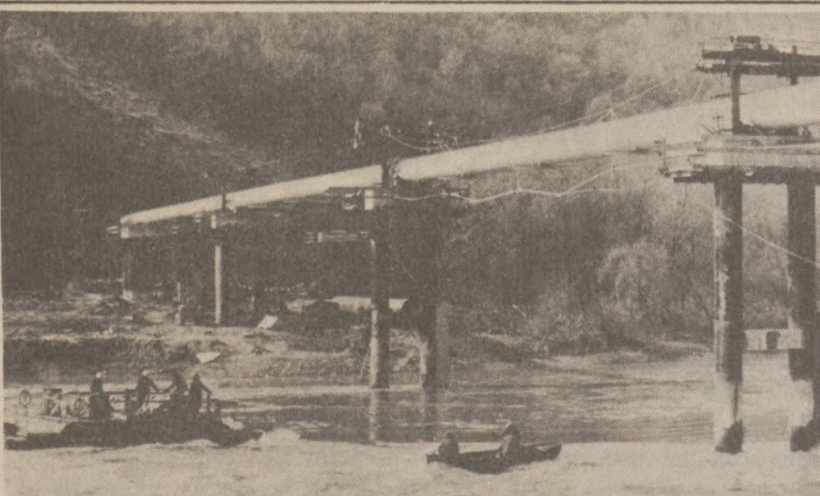
MOSKWA. — Sekcja rurociągu gazowego na odcinku przecinającym Dniestr, niedaleko Gorodenka na Ukrainie. (UPI)
