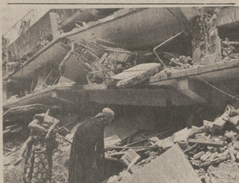
LAOAG, FILIPINY. — Silne trzęsienie ziemi jakie nawiedziło to miasto 17 sierpnia, wyrządziło poważne szkody. Na zdjęciu ocaleni przeszukują ruiny domu, w nadziei znalezienia najbliższych, którzy zostali zasypani. (UPI)
