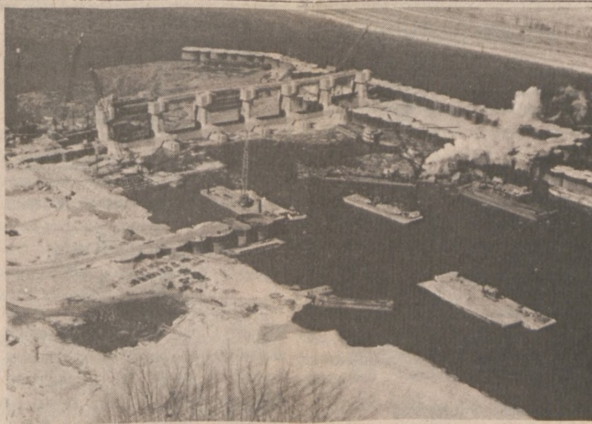
ALTON, ILL. — Prace przy budowie nowych śluz przy zaporze wodnej zwanej "cofferdam" są już prawie ukończone. Zdjęcie całego terenu objętego budową. (UPI)
