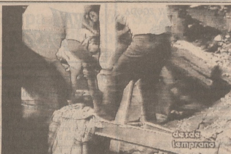
MEXICO CITY — Ekipa ratunkowa usuwa gruzy budynku, który zawalił się podczas trzęsienia ziemi. (UPI)
