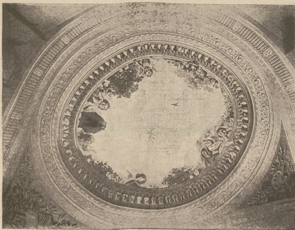
Sufit w głównej klatce schodowej.
