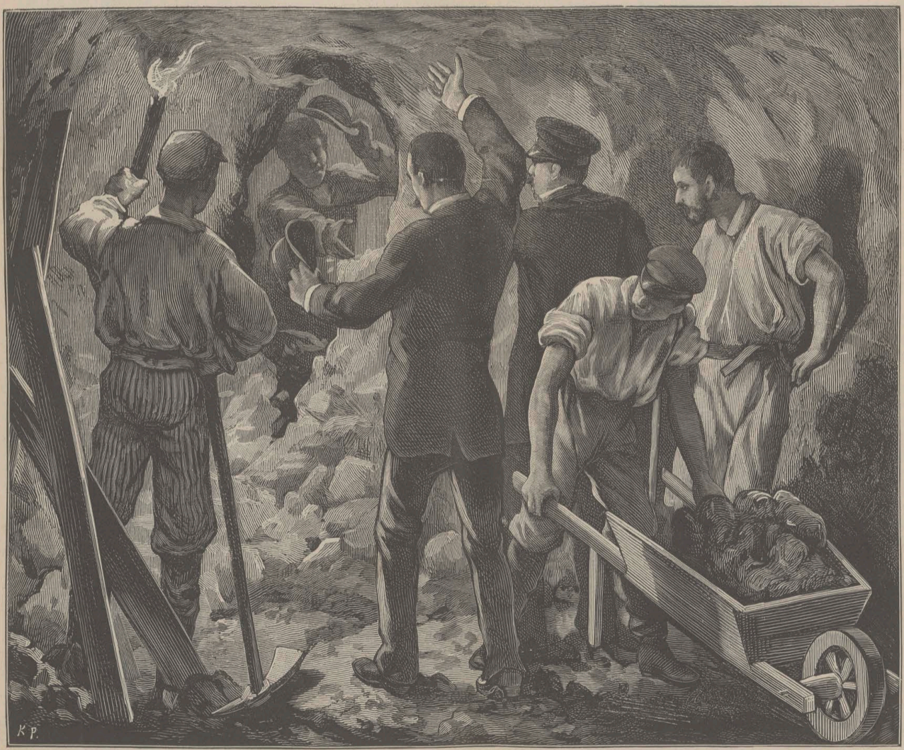
Spotkanie się robotników w chwili przebicia otworu pomiędzy dwiema galeryami w tunelu D. Ż. Iwangrodzko-Dąbrowskiej pod Miechowem.
