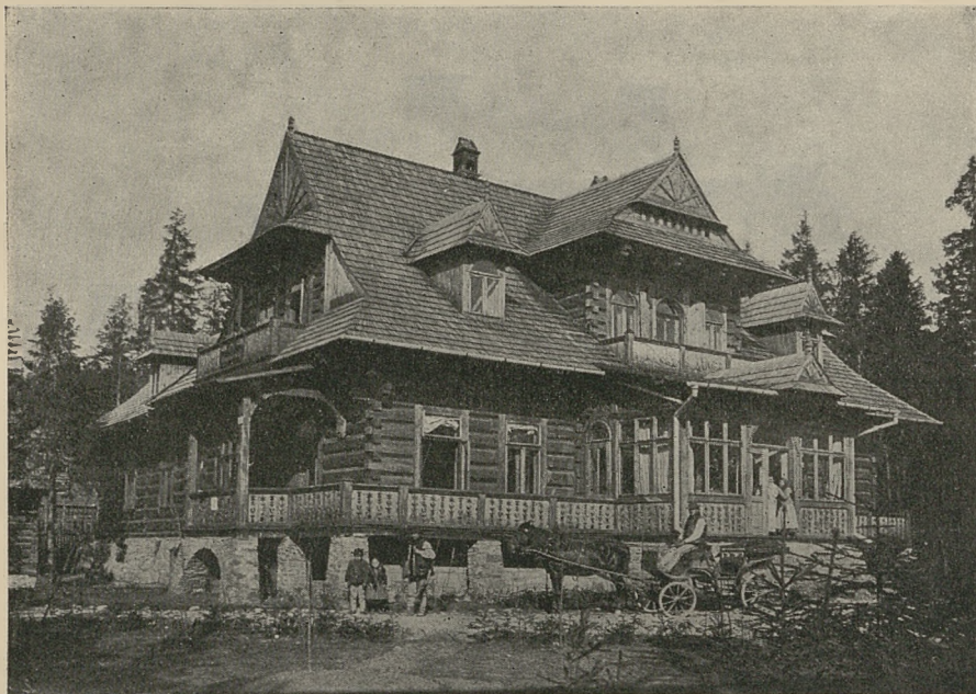
Ryc. 13. — „Obrochtówka“ przy ul. Chałubińskiego; budował J. Obrochta.
