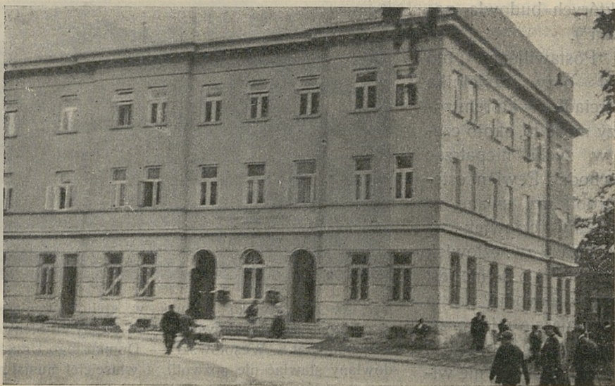
Ryc. 25. — Poczta zakopiańska po przebudowaniu.
