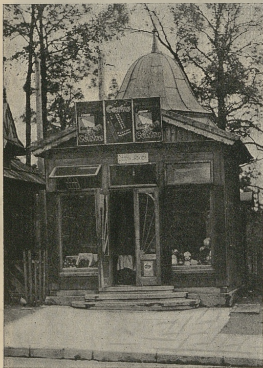
Ryc. 22. — Kiosk na nową modę obok poczty.
