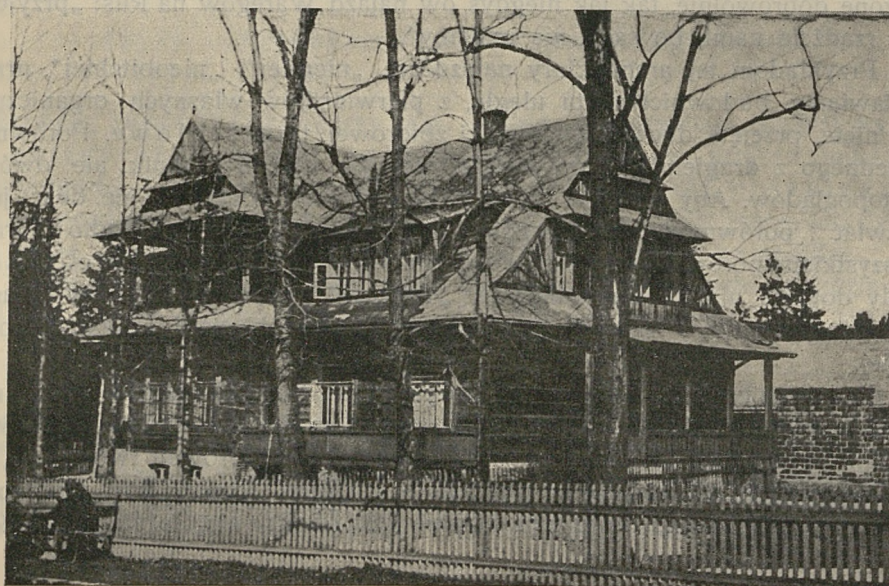
Ryc. 14. — „Cieślówka“ przy ul. Zamojskiego; budował Cieśla.
