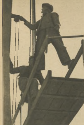
Tutaj są rusztowania mocno przymocowane. Przy innych zaś są platformy wiszące na linach.
