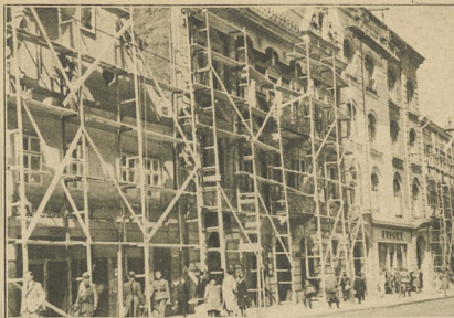
Tutaj są rusztowania mocno przymocowane. Przy innych zaś są platformy wiszące na linach.
