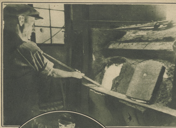
Na lewo: PRZED ROZWARZONYM PIECIEM Robotnik szklarski zajęty jest wymieszaniem masy, z której wypłapia się materiał mozaikowy.
