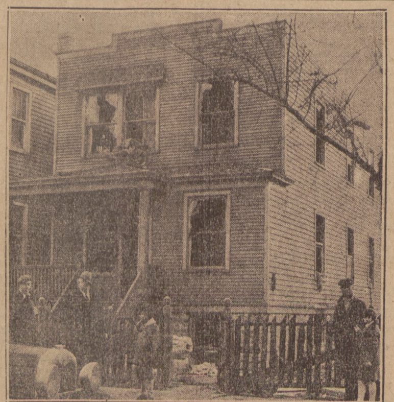
Zniszczenie dokonane przez wybuch 50-galonowego kotła i gazu pnr. 2225 N. Mansfield Ave. Wskutek odniesionych ran podczas eksplozji, Emil Lo-chise, lat 33, zmarł w szpitalu. Śledztwo ustaliło, iż Lochise zainstalował kotłociąg i połączył go rurą gazową przed gazemierzem. Połączenie musiało być niepoprawne i gaz musiał się naciekać, poczem zapalił się ognia pod kotłem. Jednocześnie eksplozja i kotłociąg.
