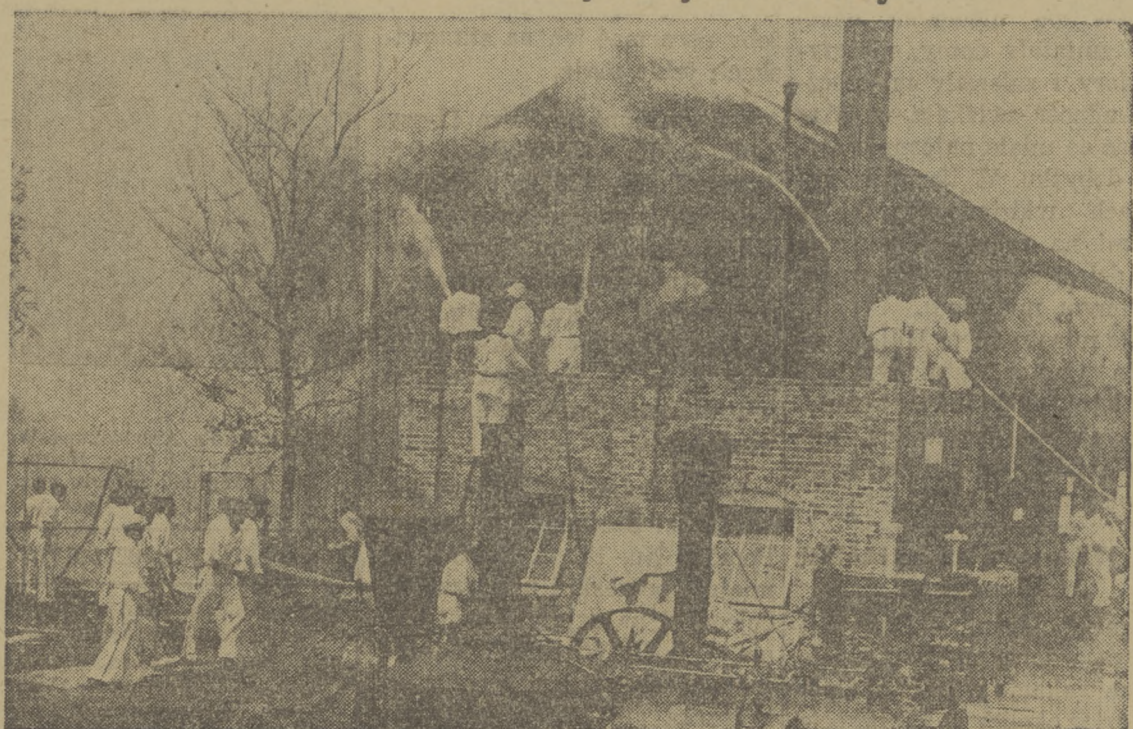
Dach na stajni Fort'a na wystawie światowej padł pastwą płomieni, które zniszczyły także maszyny etc., oraz spowodowały okaleczenie strażaka który spadł z dachu. Goście na wystawie byli świadkami tego pożaru.
