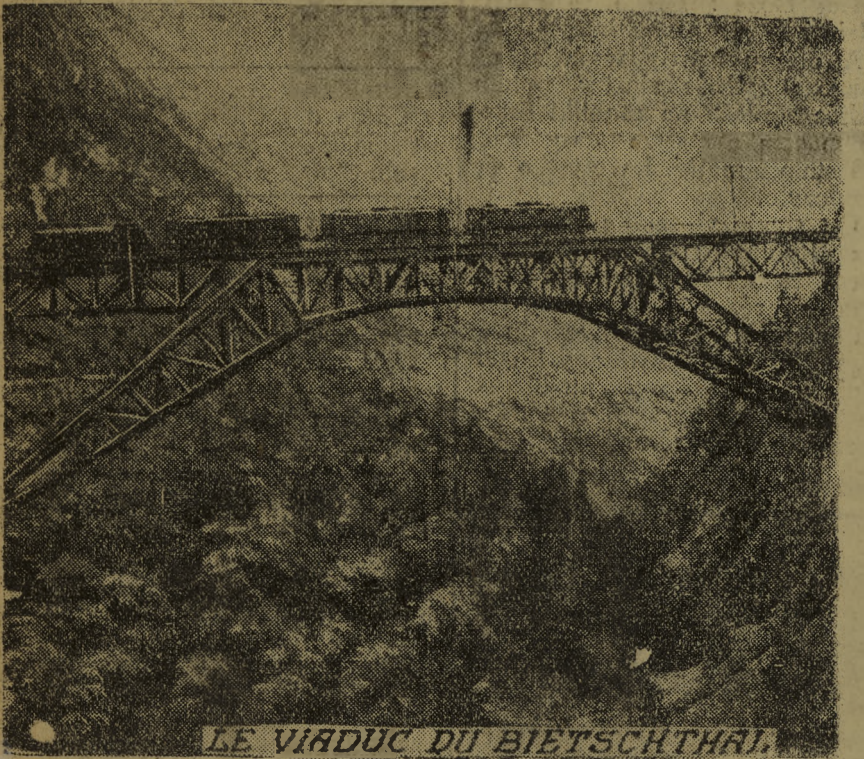
LOETSCHBERG: Wiadukt kolejowy. (P.W. 8396).
